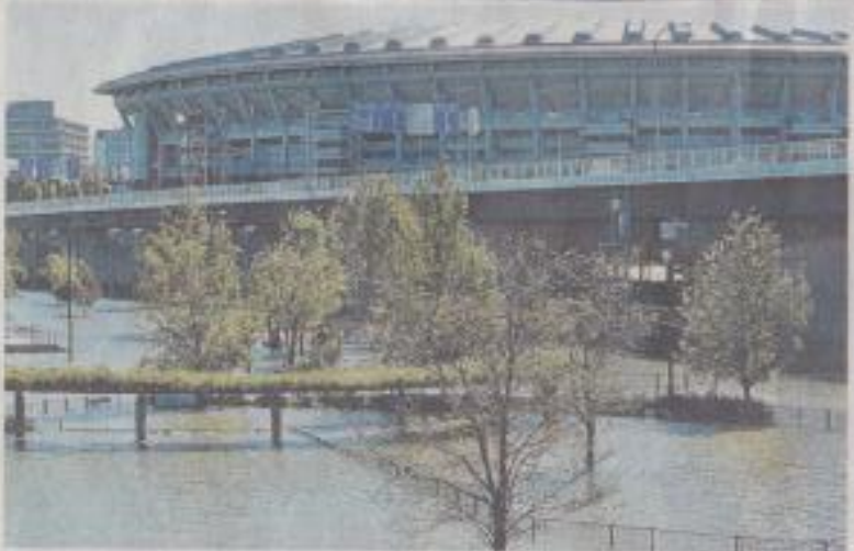
13日朝、横浜国際総合競技場の周りの遊水地には水が残っていた。横浜市内北区、林知聡撮影
