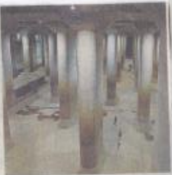
④台風19号による豪雨で、5河川から水が入り込んだ「首都圏外郭放水路」の調圧水槽。14日午後2時6分⑤通常時の調圧水槽。いずれも埼玉県春日部市。
